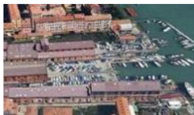
Consorzio cantieristica minore veneziana
